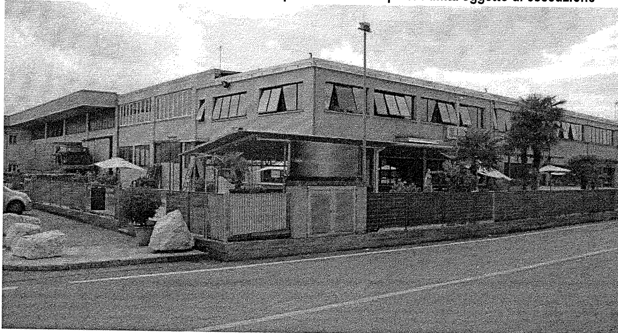
Fig. 3.7 – vista da generale da nord-est del capannone di cui è parte l'unità oggetto di esecuzione
