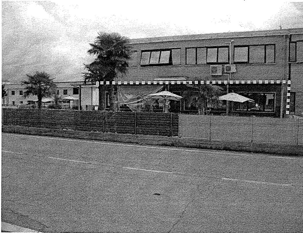
Fig. 3.8 – vista da nord dell'unità commerciale al piano terra (in tratteggio giallo) (dall'esecuzione è esclusa la tettoia visibile dalla foto)
